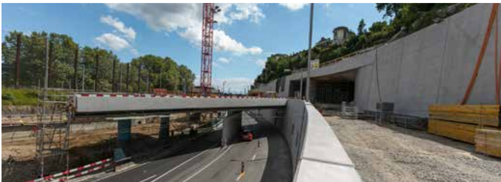
Westlicher Teil der Charlottenfelsbrücke mit dem Tunnelportal unterhalb des Schlosses Charlottenfels
