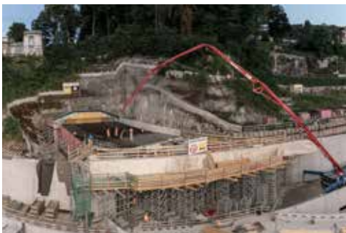
Betonieren des Tagbautunnels beim Charlottenfels
