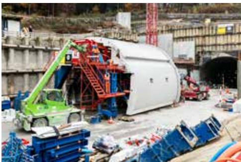
Der mobile Schalwagen für das Tunnelgewölbe
