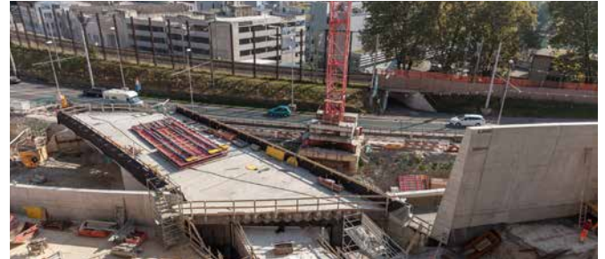
Der erste Teil der neuen Brücke zeigt die künftige Fahrtrichtung an
